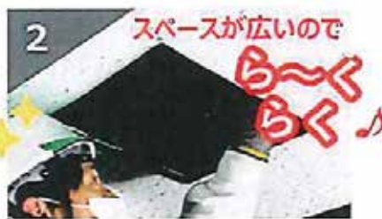
ダクトと 取付楽ちん枠 の間にアルミテープ等を貼る。
