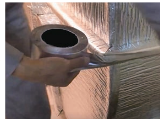
フランジカバーの外側に アルミテープを巻き回す
