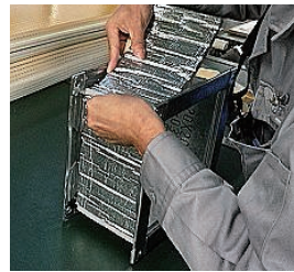
ダクト側面にダクト断熱エース本 体を貼付け
