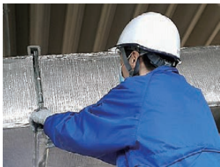
断熱ダクトピース同士を接続
